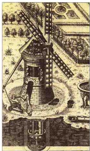
Ветряная мельница, поднимающая воду для водопровода и фонтанов
